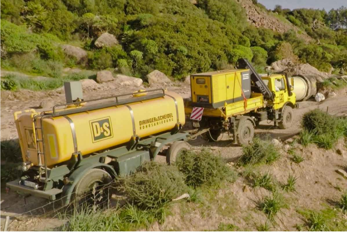
Transportul apei pentru lucrarile de injectare.
