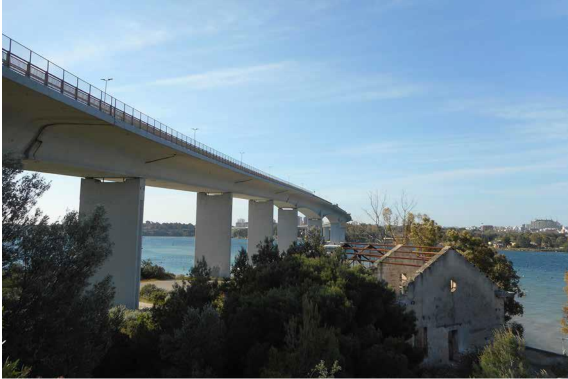
Podul „Punta Penna Pizzone di Taranto“ ridicat in 1977 este considerat a fi unul din cele mai lungi poduri din beton precomprimat din Europa.
