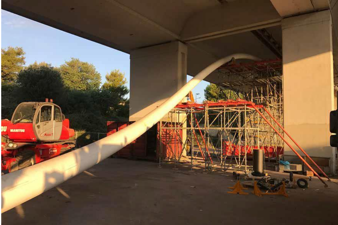
Podeste intermediare cu capre cu ruloari destinate ridicarii conductelor la inaltimea podestului de lucru pentru echipamentul de suspendare.
