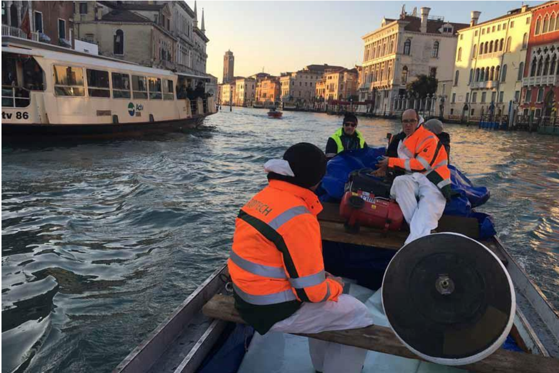
Calatorie neobisnuita: Drumul pitoresc intre instalatia de impregnare si locul de montaj parcurs de BlueLiner cu barca pe Canalul Grande.
