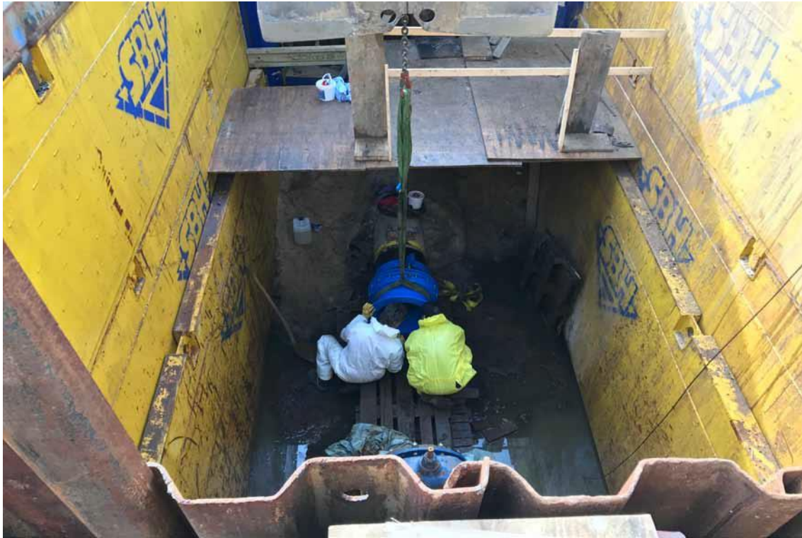
Montajul unei flanse speciale, prin care BlueLinerul este introdus in conducta care urmeaza a fi reabilitata.
